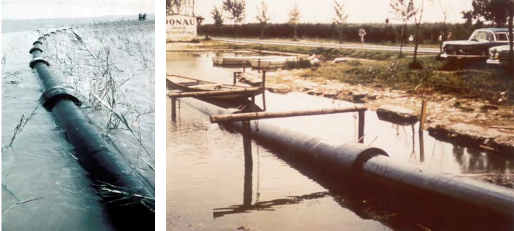
Abbildung 32: Trinkwasserleitung (AZ 400) durch den Neusiedlersee von Seewinkel bis Illmitz während des Verlegens (Bildquelle: WLW Nördliches Burgenland).
