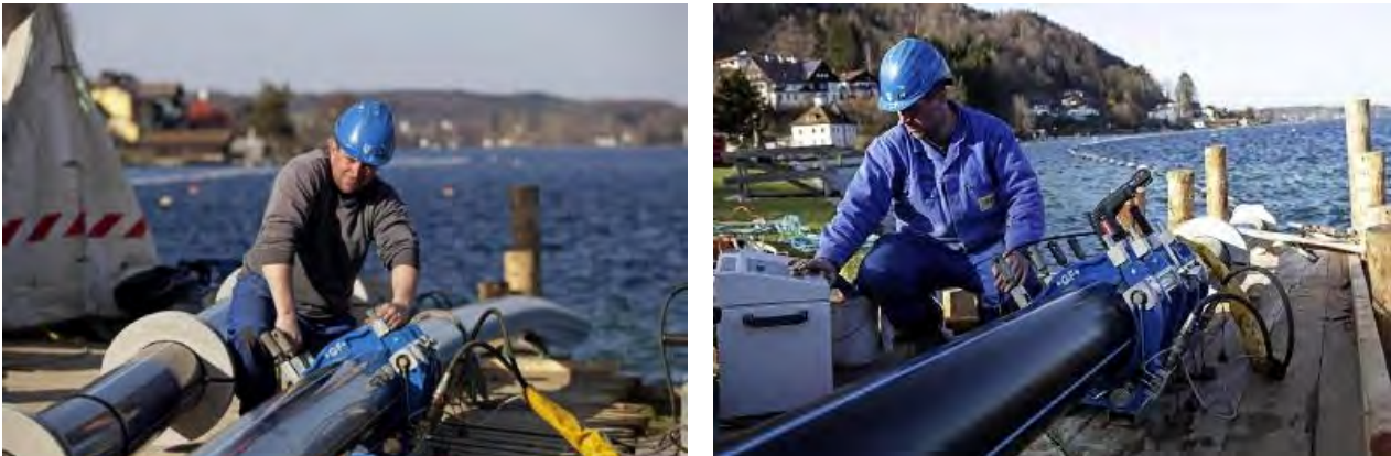
Abbildung 82: Endmontage und Lagerung der 2,6 km langen Trinkwasserleitung im Attersee im Jahr 2009 (URL: http://www.energieag.at/ [20.07.2015]).
