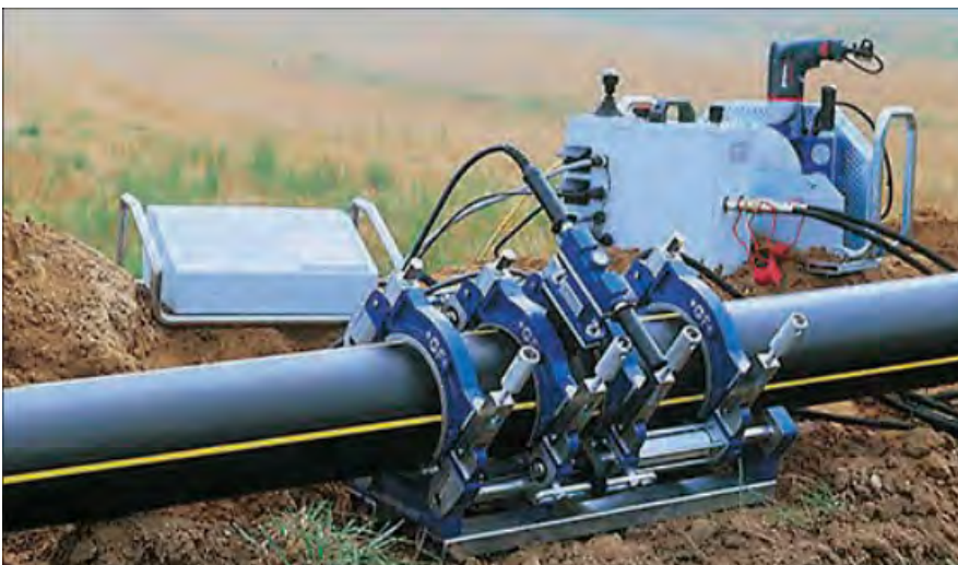
Abbildung 9: Herstellung einer Stumpf-/Spiegel-Schweißung (Jansen, 2014).
