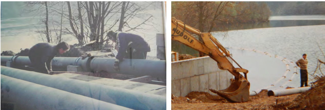
Abbildung 16: Herstellung der Seedruckleitung aus Gussrohren (Bildquelle: AWV Völkermarkt-Jaunfeld). Links: Montage der Einzelrohre mit nur kleinen Beschwerungsgewichten an der Unterseite, Rechts: Schwimmende Rohrstränge vor dem Absenkvorgang.
