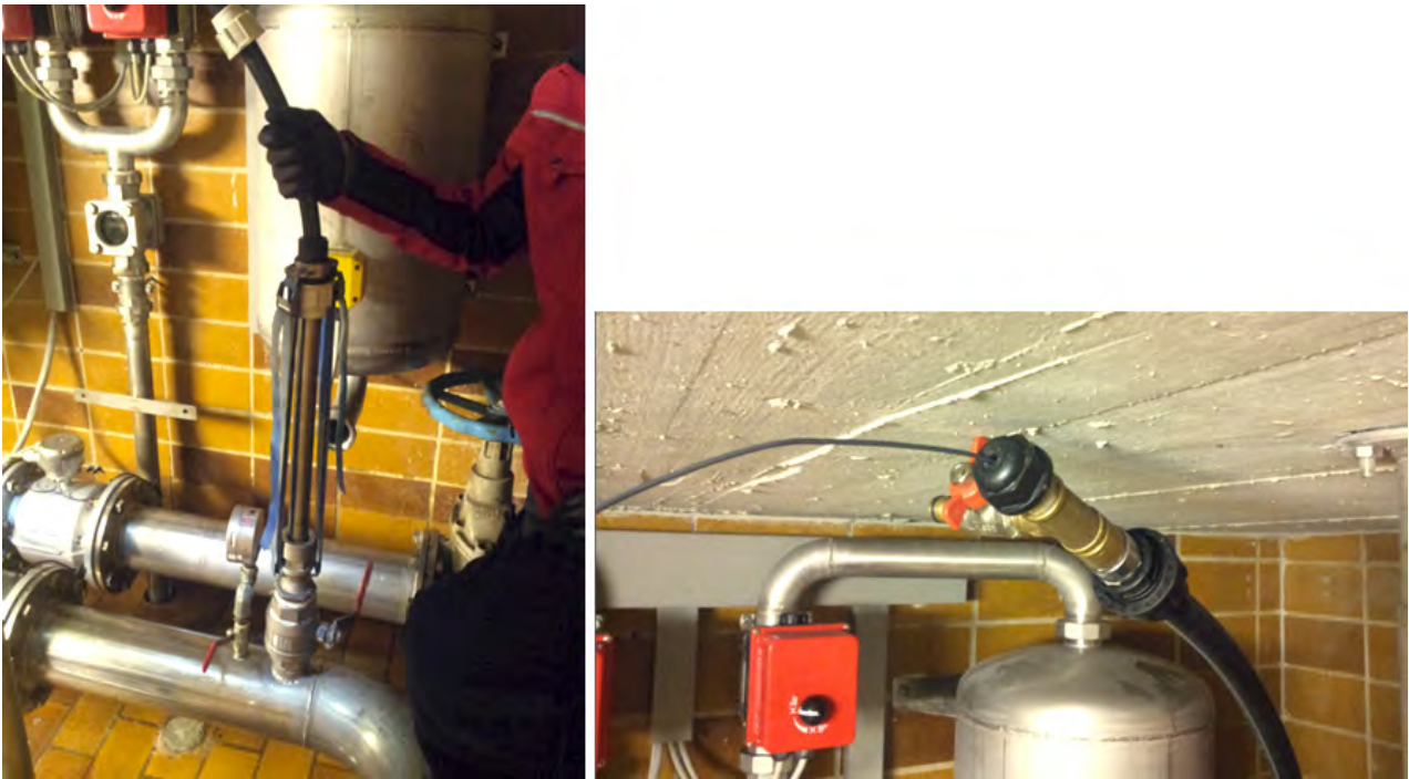
Abbildung 59: Einschwemmverfahren / Einziehen des Stahlseils.
