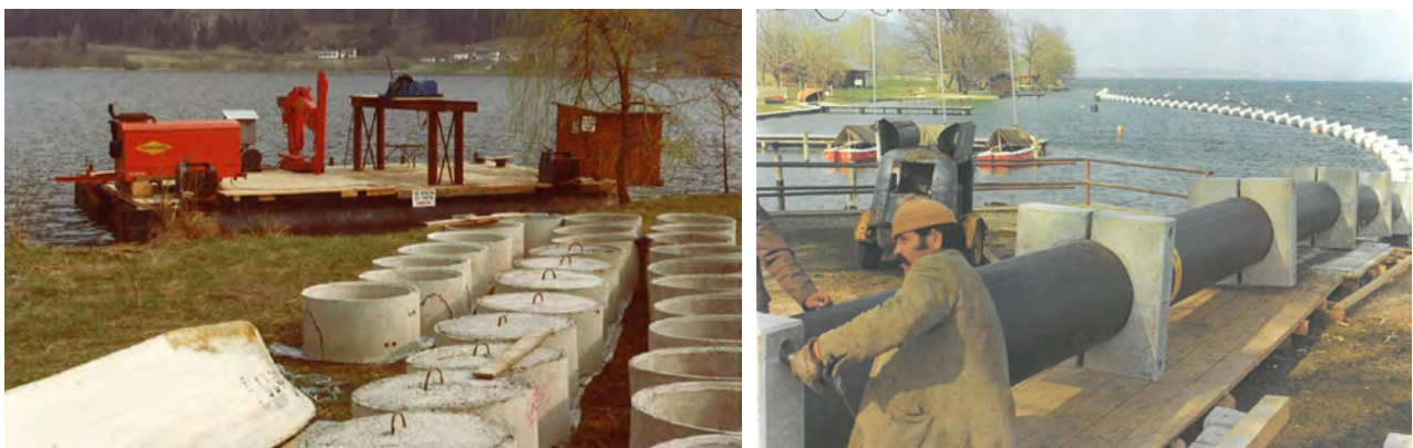
Abbildung 14: Links: Positionierungsgewichte (Bildquelle: WV Ossiacher See); Rechts: Montage der Beschwerungsgewichte Mai 1975 (Bildquelle: RHV Attersee).
