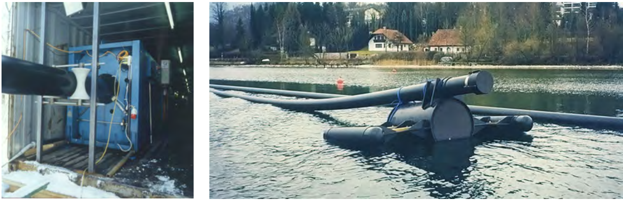
Abbildung 83: Produktion und Lagerung der 6,5 km langen Trinkwasserleitung im Traunsee im Jahr 1998 (Bildquelle: AGRU Kunststofftechnik GmbH).
